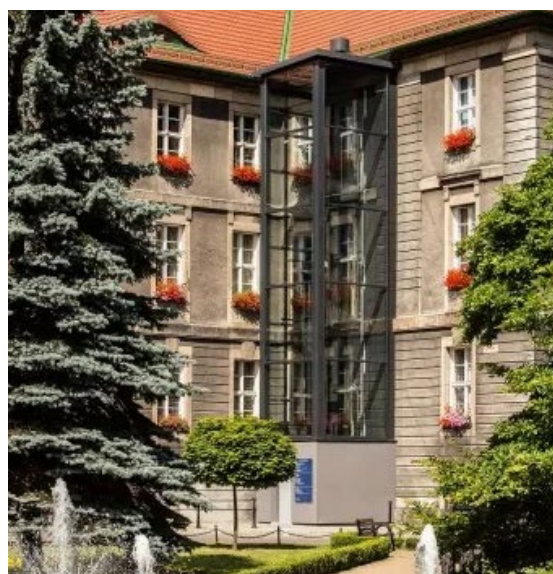
Zewnętrzna winda nie zaburza wyglądu bryły zabytkowego budynku w Bytomiu
